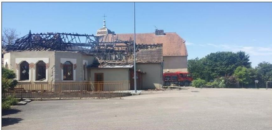
Le bâtiment communal après l'incendie à Mercy-le-Grand. Archives Progrès/Denis GARNIER
